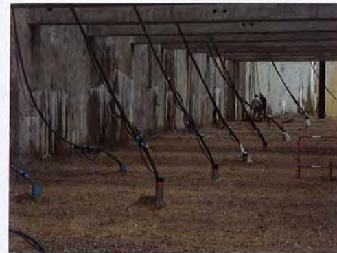
Photographie 65 : Parc souterrain Brotteaux à Lyon (69 – France) : dispositif de rabattement de nappe comportant plusieurs puits de petit diamètre avec crépine en PVC ou à fil enroulé captant la molasse (sable fin à moyen, plus ou moins consolidé) (photographie G. Monnier)
