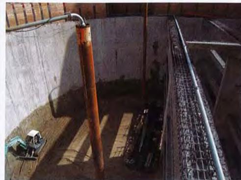
Photographie 66 : Deux puits (non recépés) de rabattement de nappe aux alluvions, visibles en fond de fouille (chantier du parking souterrain Brotteaux à Lyon (69) – photographie G. Monnier)
