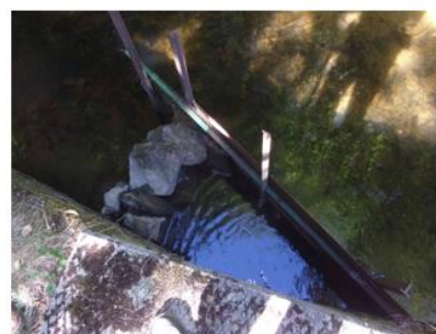
Tôle pleine et blocs permettant la prise d'eau vers le bac de prise
