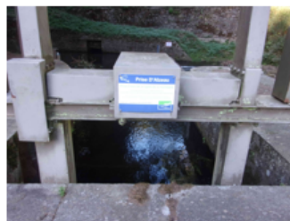
Télégestion sur la vanne de la prise de l'Alzeau
