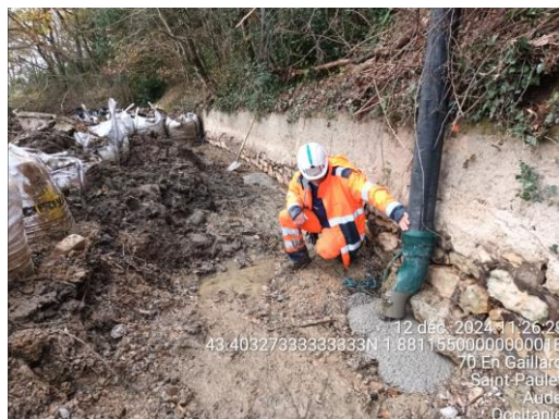
Comblement par bétonnage
