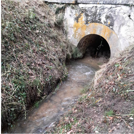
Résurgence au niveau de la sortie d'un aqueduc de la rigole
