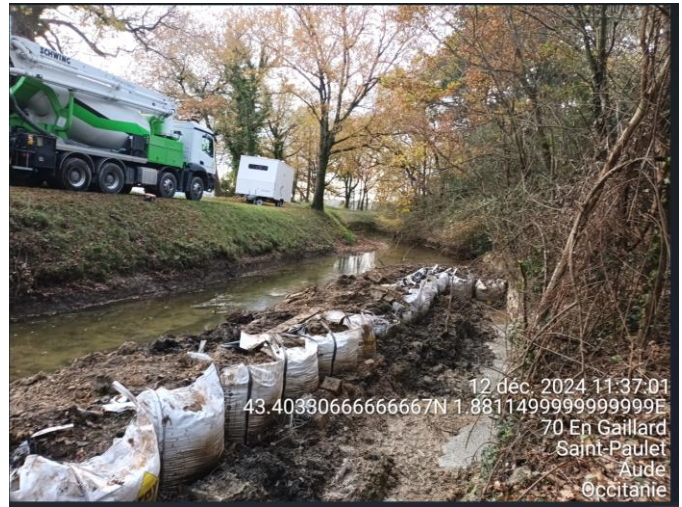
Mise en place d'un batardeau
