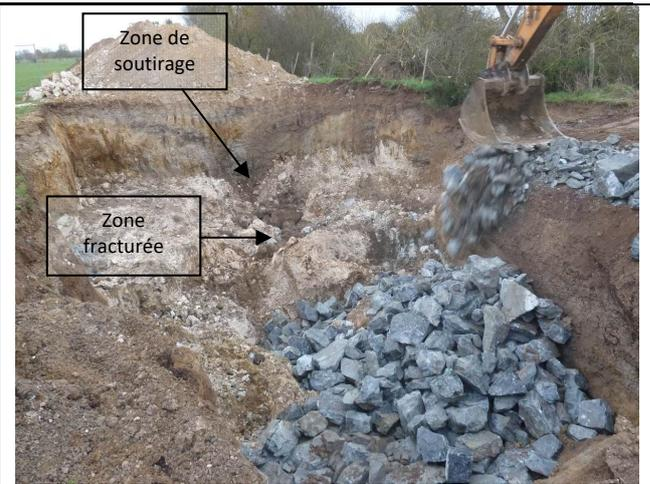
Figure 9 : Apport de gros blocs pour le comblement de la zone fracturée – Vue générale de la fosse
