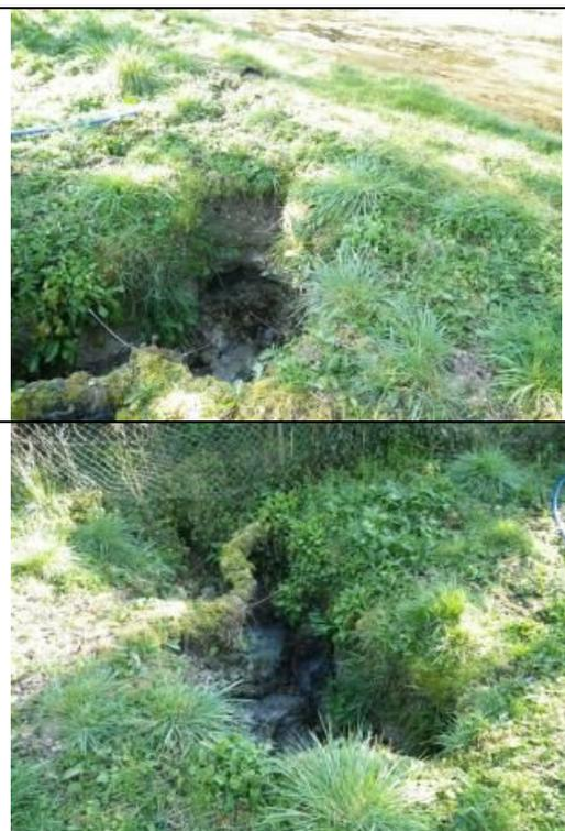
Figure 2 – Effondrements apparus sur la digue du bassin du Vivier
