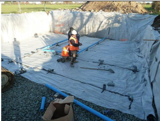
Figure 10 : Mise en place du réseau de décompression et pose de bidim sur les parois de la fosse
