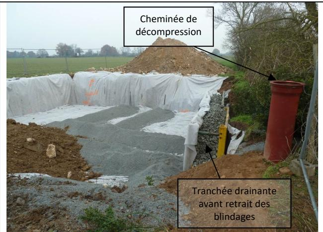
Figure 11 : Comblement final par les terres excavées au-dessus du massif de gravier protégeant le réseau de décompression
