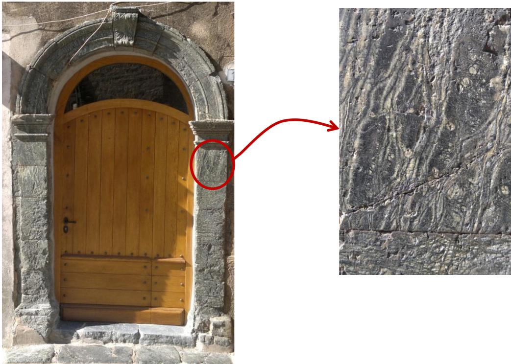
Figure 6 : Serpentine prélevée dans la Chartreuse, réutilisée pour le contour d'une porte dans le vieux village de Cogolin.
