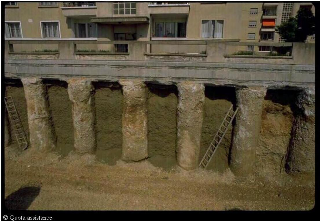
Figure 3 - Dégarnissage d'une zone traitée par jet grouting
