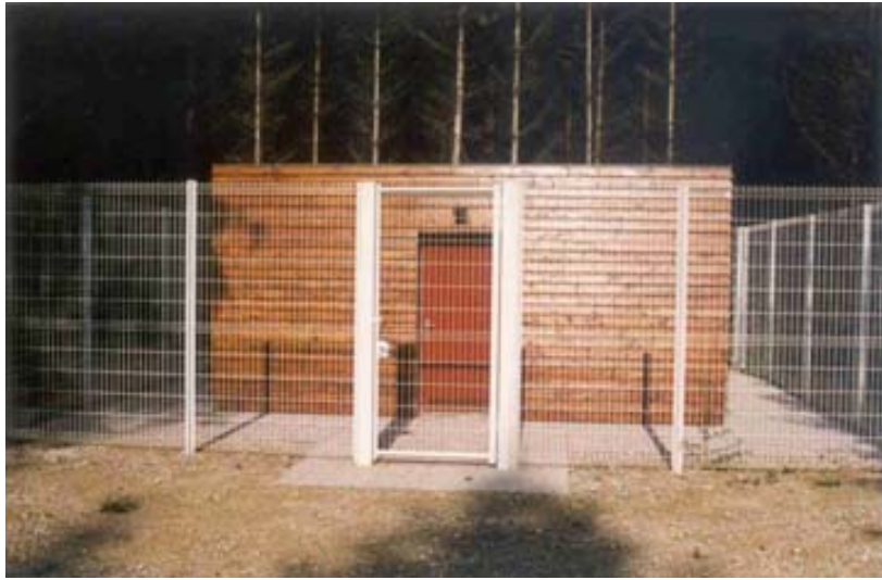
Figure 1. Une émergence Hépar protégée par un abri sécurisé et le PSE clôturé
